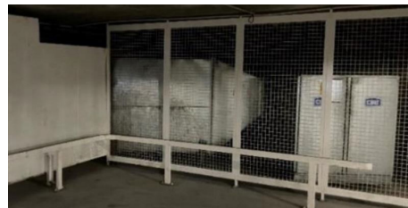
Remplacement de la chaudière
