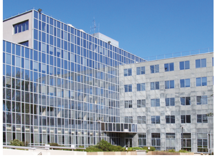
▼ 183, avenue Georges Clémenceau - Nanterre (92)
