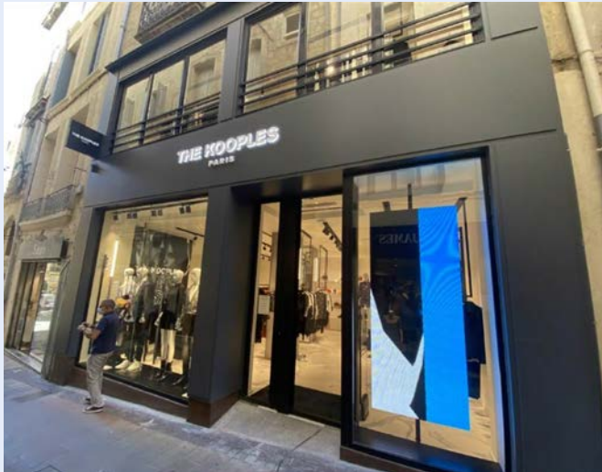
Rue de l'Argenterie - Montpellier (34)
