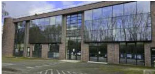
L'immeuble de Trappes était soumis à un risque d'inconfort thermique pour les locataires du fait de sa verrière. En cas de vague de chaleur, les vitrages laissent passer les rayons infrarouges du soleil, ce qui réchauffait l'intérieur du bâtiment. Les locataires étaient alors obligés de climatiser l'immeuble.
